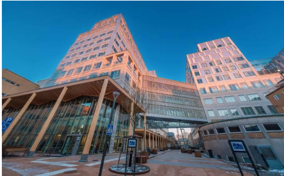
Figur 5: Byggnad 35 och 36 sammanlänkade med en förbindelsegång. Foto: Pierre Ekman.
