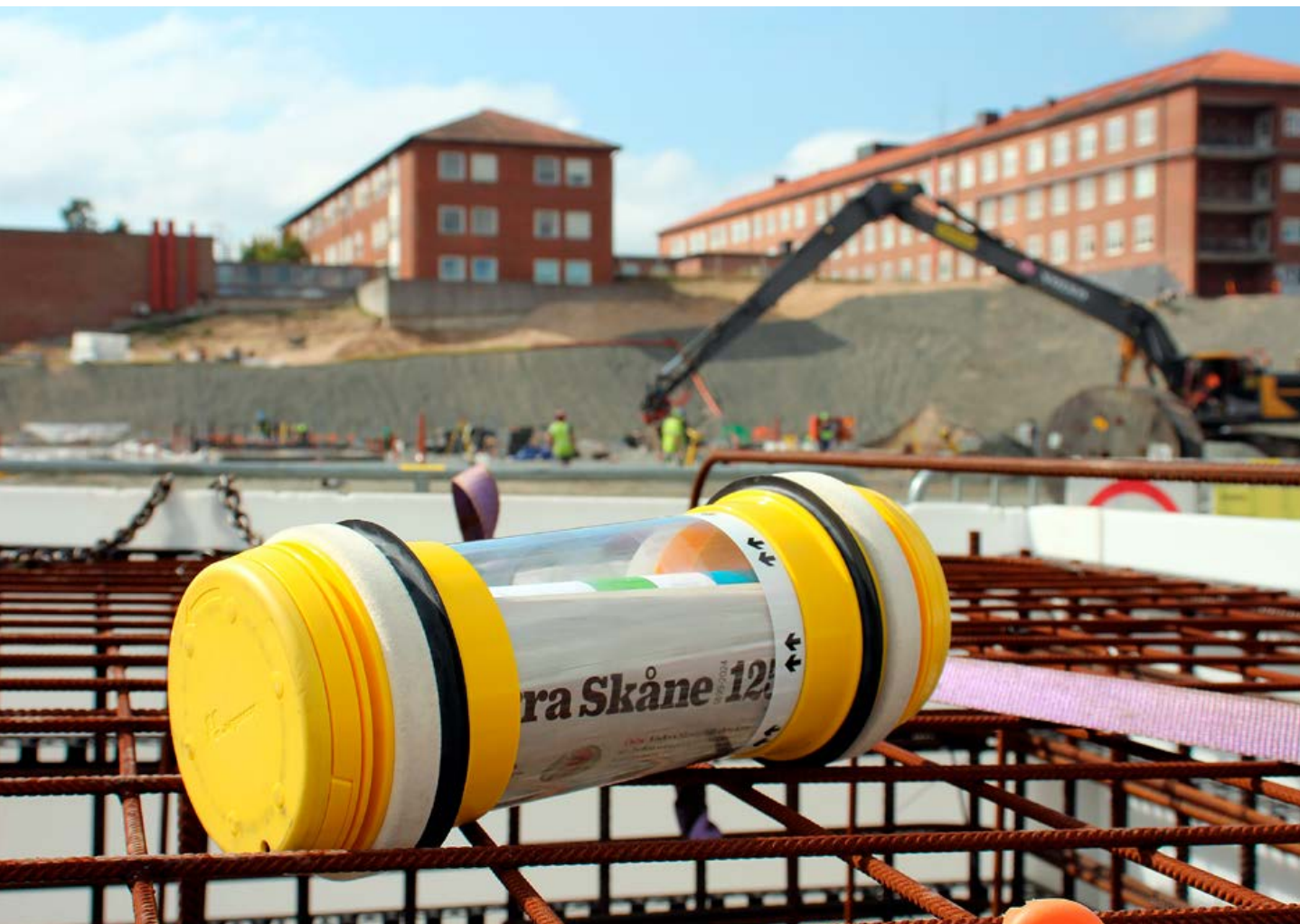
Byggstart av Forth (Framtidens ortopedi i Hässleholm). En tidskapsel gjuts in i betongfundament i vårdbyggnadens bottenplatta.
